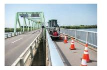
歩道橋等が点検対象橋梁に近接 し、橋梁点検車の使用が困難な場合 も近接している歩道橋等から点検が 可能です。それにより対象橋梁の交 通規制の回避をすることが出来ます。
