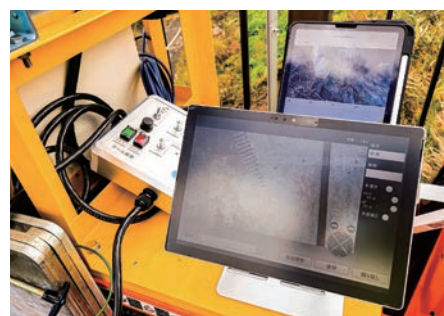
タッチパネル式 カメラ操作盤
