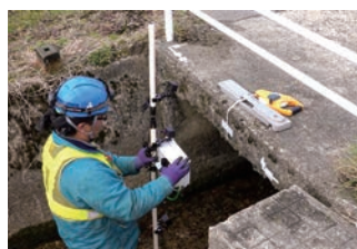
地覆撮影状況
