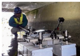
床版撮影状況
