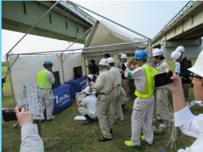
点検カメラの画像をモニターで確認中
