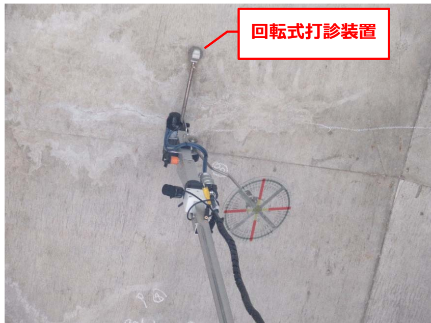
打診・クラックゲージ台車でクラック幅を測定中
