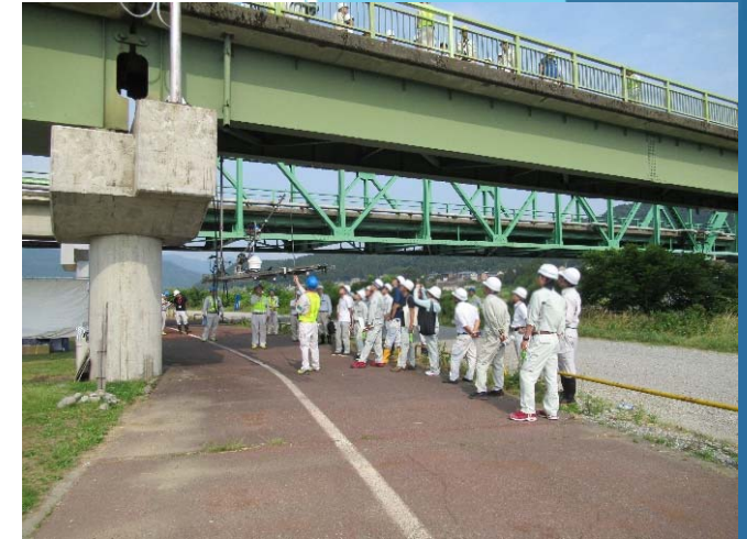
受講者は桁下でロボットアームの動作を確認中
