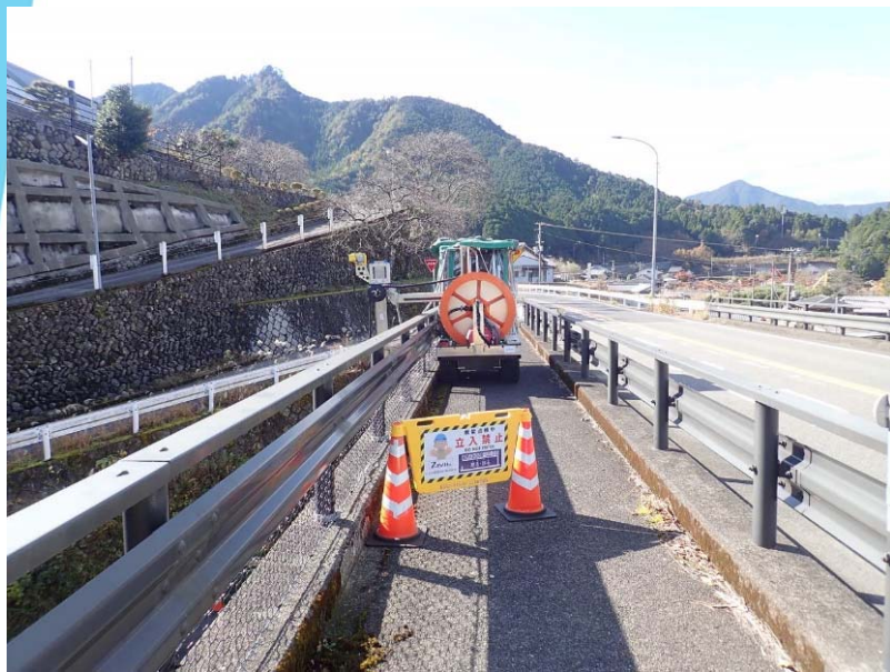
歩道規制で点検作業開始です。
