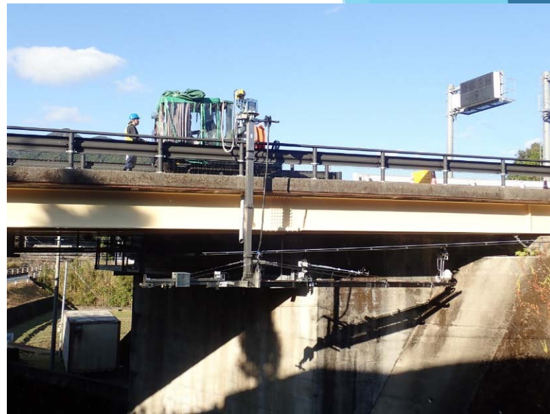
電話線をよけながら支承周りを点検中です。
