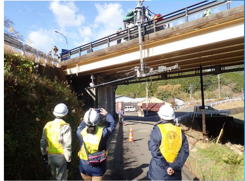
橋の下からもアーム及び台車の動きを確認して頂きました。
