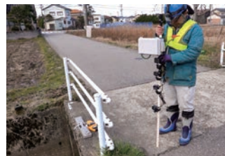
橋面・ガードレール撮影状況
