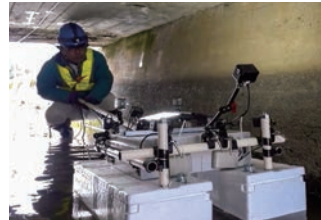
床版撮影状況
